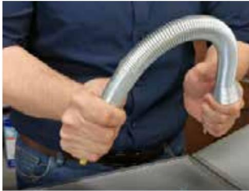
En caso de requerirlo, doble la tubería utilizando el resorte doblador. Esto le permitirá cambios de dirección sin utilizar conexiones en codo. Introduzca el resorte en la tubería, sujete los extremos y proceda a hacer el doblado hasta el ángulo deseado, respetando el radio mínimo de 5 veces el diámetro exterior de la tubería utilizada.
