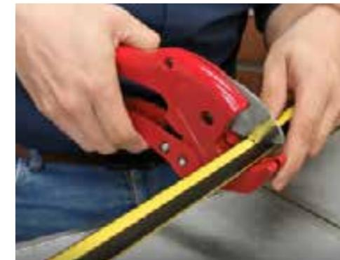
Mida la distancia requerida y realice un corte recto en la tubería, es esencial que el corte sea realizado con las tijeras suministradas por Coflex. No utilice otro tipo de herramientas, cortes realizados con filos tipo sierra propician una instalación deficiente y con probabilidades de fuga.
