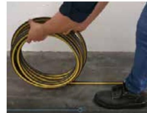
Para comenzar con la instalación, desdoble la tubería, apoyando la bobina en el piso para lograr que la tubería se desenrolle lo más recta posible. Procure no presionar de manera excesiva contra el suelo.
