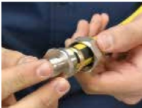
Inserte la conexión dentro de la tubería y ensamble los componentes, apriete manualmente la contratuerca hasta el tope y posteriormente, apriete la conexión girando  $\frac{1}{2}$  vuelta más con ayuda de un par de pinzas ajustable.
